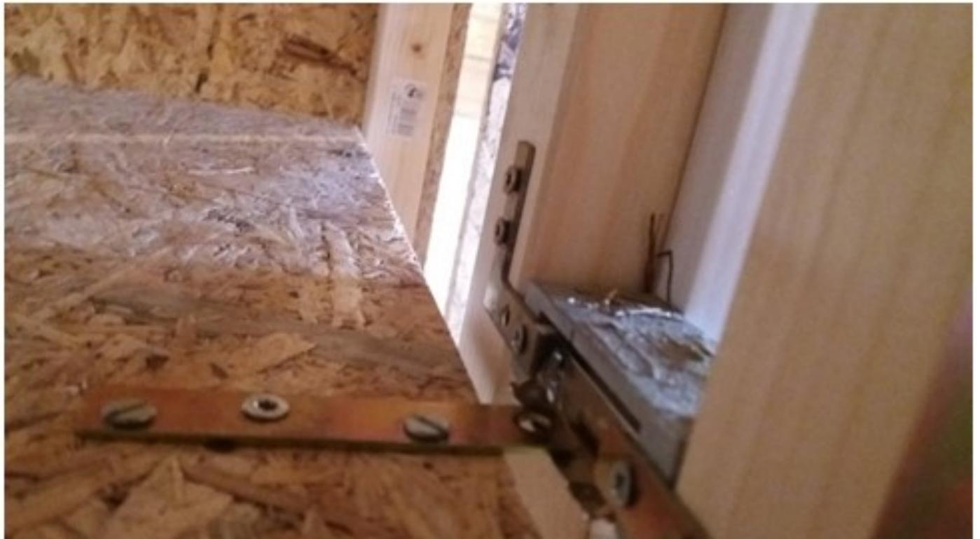
*Die Klappen werden in ein elektrisches Türschloss eingehängt.*
