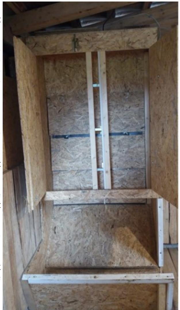
*Der geöffnete Schrank von vorne – das Heu fällt von den Klappen direkt nach unten in die Raufe.*
