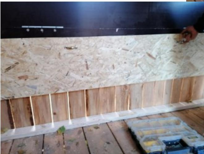
Um zu verhindern, dass sich durch Heu oder Stroh die Seitenwände nicht absenken können, wurde im Inneren noch eine zusätzliche Platte installiert (Führung in U-Profilen). Diese sollte sich nach oben öffnen lassen, um so Stroh aus
