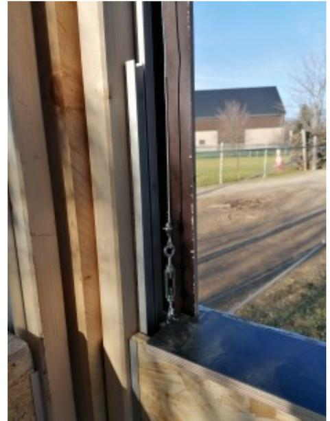
Wichtig ist dabei, dass der Mechanismus die Seitenwände von **unten** nach **oben** schließt. Ansonsten besteht die Gefahr, dass die Tiere mit dem Kopf hängen bleiben oder eingeklemmt werden. Der Reflex der Tiere ist so ausgerichtet, dass der Kopf der Tiere nach oben geht.
