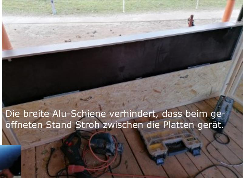
Die breite Alu-Schiene verhindert, dass beim geöffneten Stand Stroh zwischen die Platten gerät.
